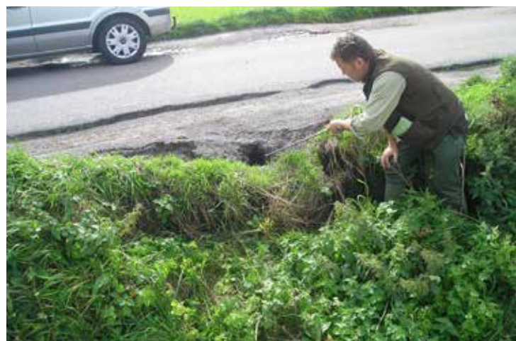
Boven: Schade door graverij van muskusratten kan in een enkel geval, op de verkeerde plek, een reële kostenpost worden of daadwerkelijk risico voor de veiligheid opleveren (foto: HDSR).
